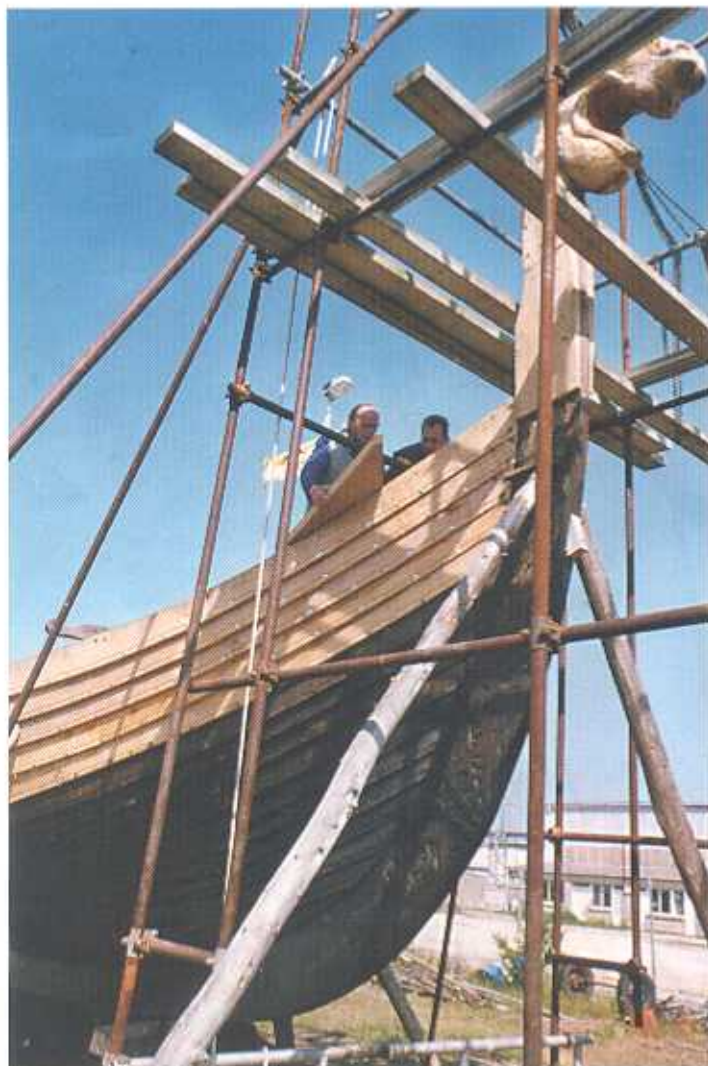
Ci-dessous : L'étrave a été ornée d'entrelacs inspirés du bateau d'Oseberg (musée d'Oslo-Bygdøy). La partie inférieure de la coque est passée au goudron de Norvège.
